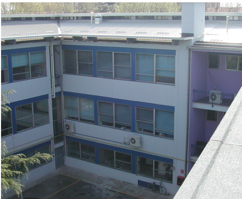
Edificio principale (lato Ovest), vista da cortile interno
