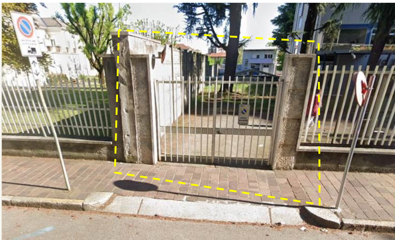
IDENTIFICAZIONE DEL CANCELLO CARRAIO DI VIALE ROMA
