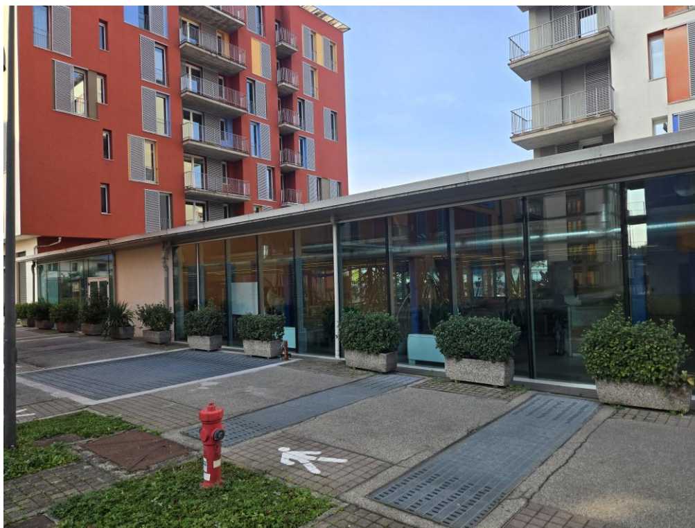
Figura 2. Vista della zona reception e sala polifunzionale dal cortile interno Arpa
