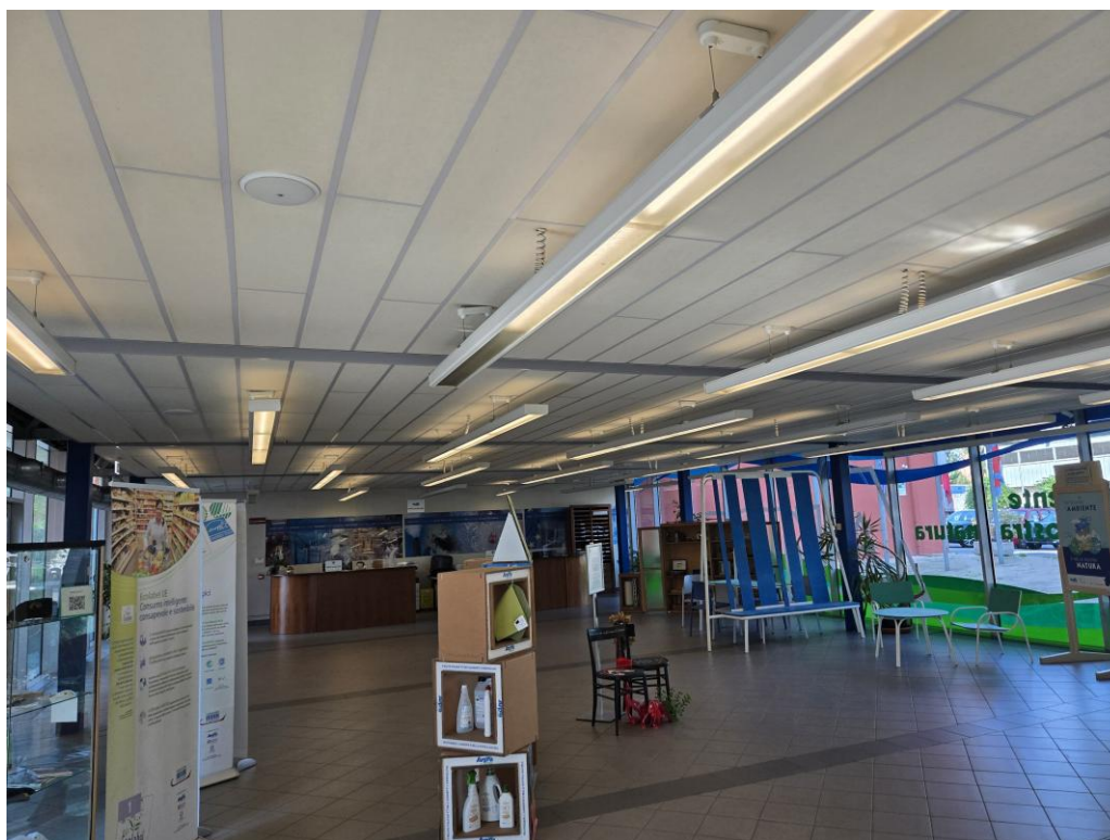
Figura 3. Stato attuale della controsoffittatura interna
