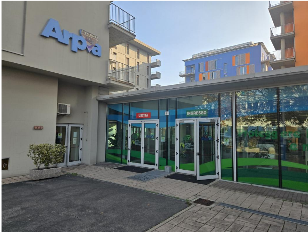
Figura 1. Ingresso reception Arpa oggetto d'intervento
